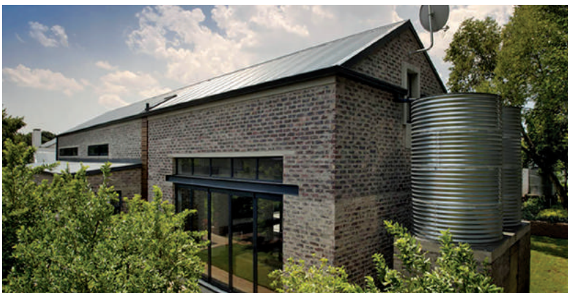
MODULO The Link House CENTURION, SUDAFRICA
