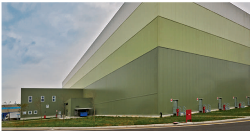
NUOVO ELEVETOR Stabilimento Santex Sarego VICENZA, ITALIA
