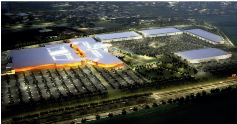
ELEVATOR TANK Centro Commerciale MondoJuve TORINO, ITALIA
