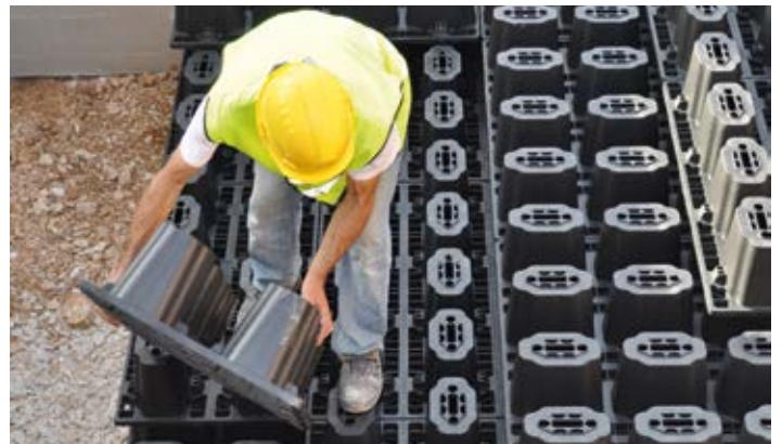
Figura 17 - Posa in opera del Drainpanel
