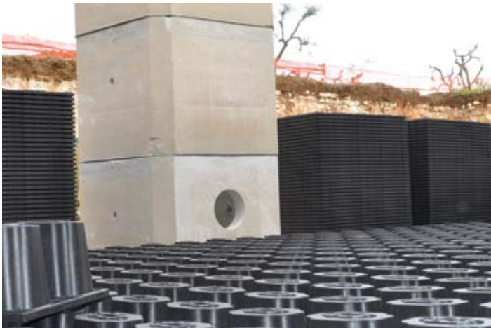
Figura 21 - Punto di accesso al sistema per l'ispezione
