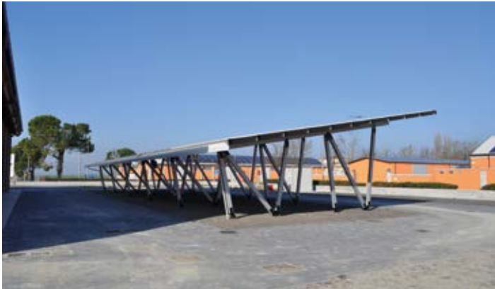
Figura 12 - Completamento con finitura a parcheggio
