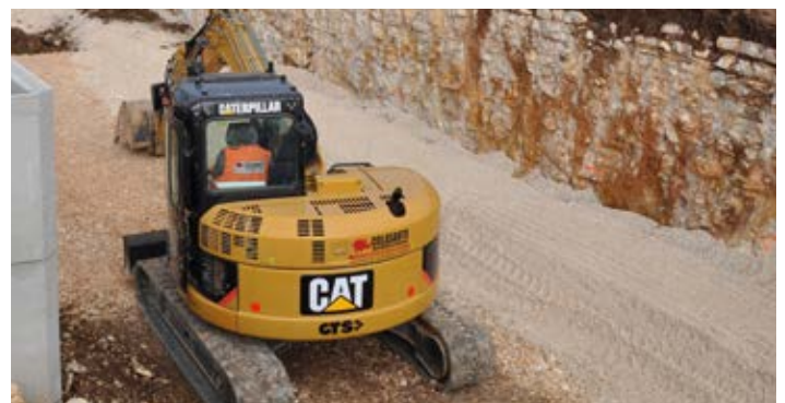
Figura 11 - Fase di ricoprimento e rinfianco del sistema Drainpanel
