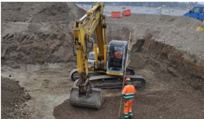
Figura 16 - Fase di scavo e preparazione del fondo
