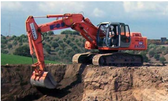
Figura 7 - Scavo e preparazione del fondo
